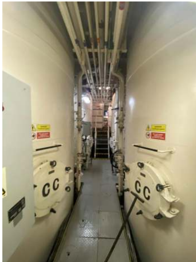
110. 4 nos. Dry bulk tanks.
